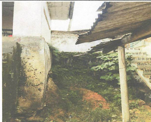
ANTES DA CONSTRUÇÃO DO WC
